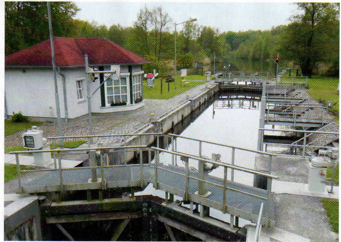
„Schleuse Hermsdorfer Mühle“
